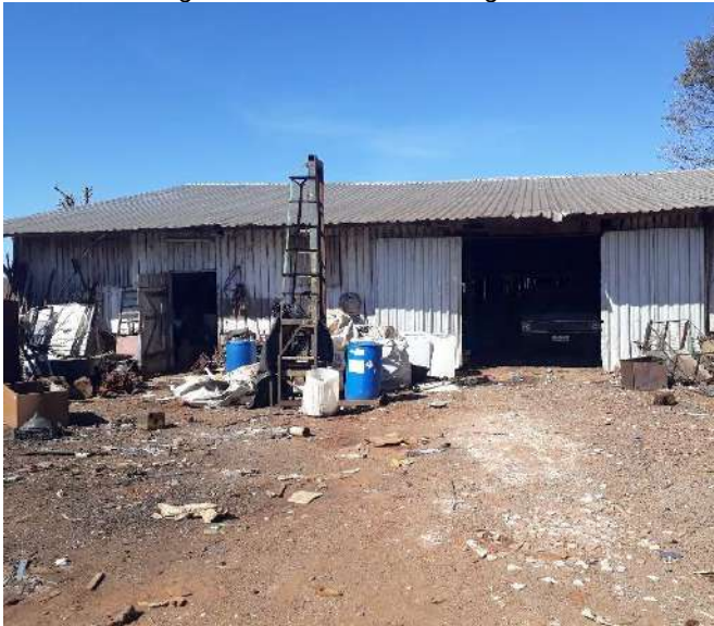
Figura 33 – Pavilhão de Triagem
