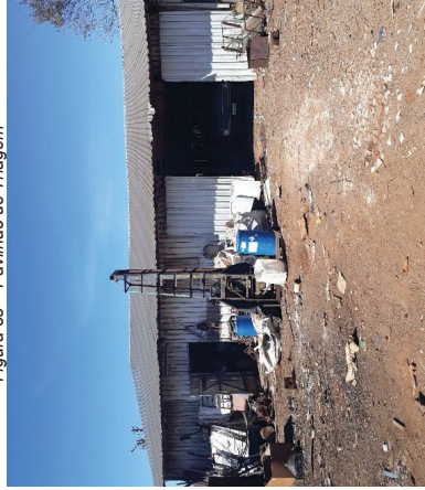
Figura 33 – Pavilhão de Triagem
