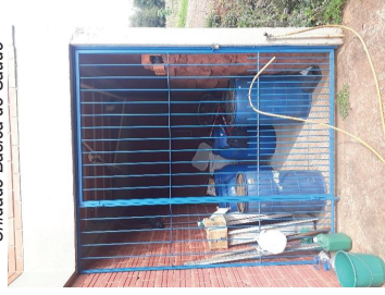
Figura 54 - Armazenamento das bombonas - Unidade Básica de Saúde
